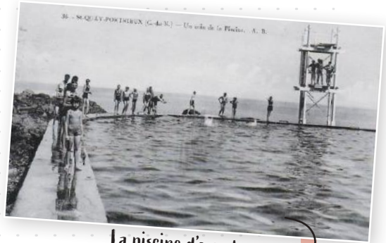
La piscine d'eau de mer fut inaugurée en 1929.
